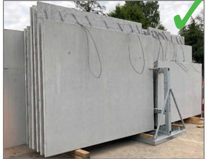
Bei Anlieferung der Wandelemente auf der Baustelle ist es oft nicht möglich, die Elemente direkt vom Fahrzeug aus an Ort und Stelle zu montieren. Dies bedeutet, dass die Teile zwischengelagert werden müssen, was eine erhebliche Beschädigungsgefahr bedeutet, wenn die Wandelemente auf den Boden gelegt oder an Wände oder Böschungen gelehnt werden.
