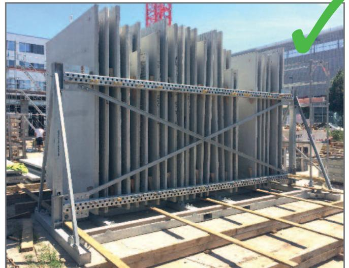
Auch auf Ortbetonbaustellen mit Wandschalungen oder großen Fertigteilen sorgen die Rechengestelle für Ordnung und Sicherheit. Ein weiterer positiver Effekt: Enorme Zeitersparnis beim Auswählen der einzelnen Elemente.
