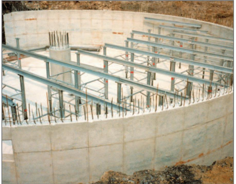
110 Aluminium-Stützen im Einsatz – ursprünglich geplant waren 310 Stahlstützen
