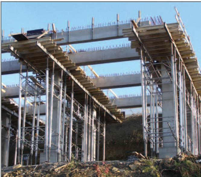
Gerüsttürme für Ortbeton-Unterzüge mit aufgelegten Nebenträgern aus Fertigteilen
