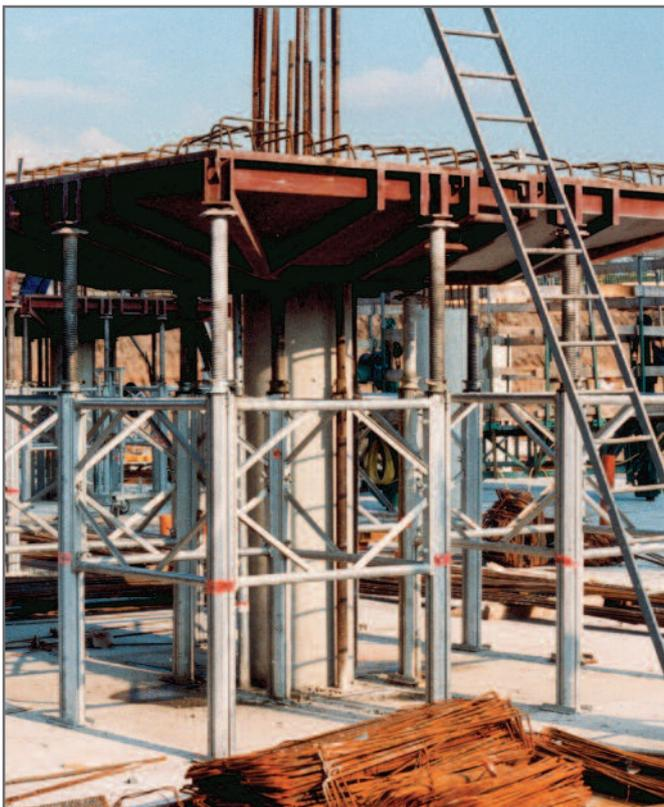
H-Rahmen zur Stabilisierung der Unterstützung einer Sonder-Pilzkopf-Schalung
