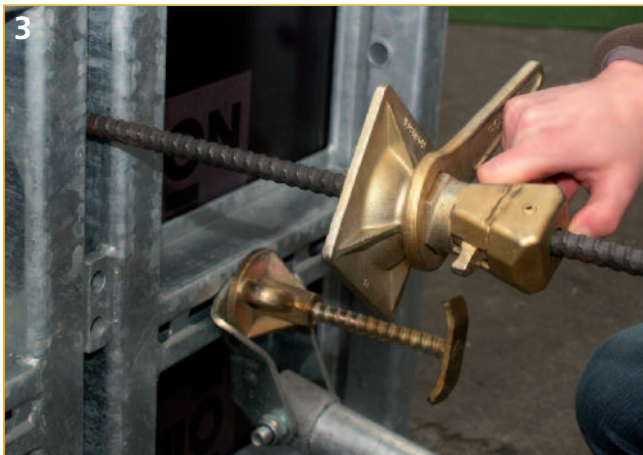
3 Nach dem Stellen der Schließ-Schalung die Schnellspan-Mutter SSM einfach über den Ankerstab schieben bis die Gegenplatte an der Schalung anliegt – kein Schrauben erforderlich!
