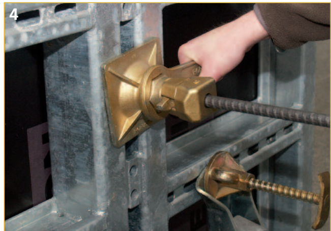
4 Anpressen der Mutter bequem von Hand durch Drehen mit dem Ringschlüssel.
