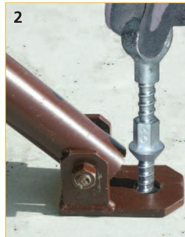
2. Schraube bis zum Ankergrund eindrehen
