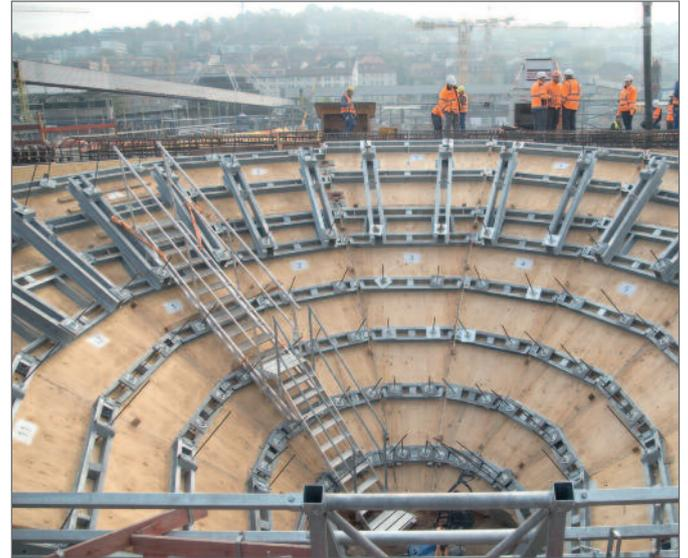
Abb. links: Bewehrungsarbeiten im Kelch-Auge
