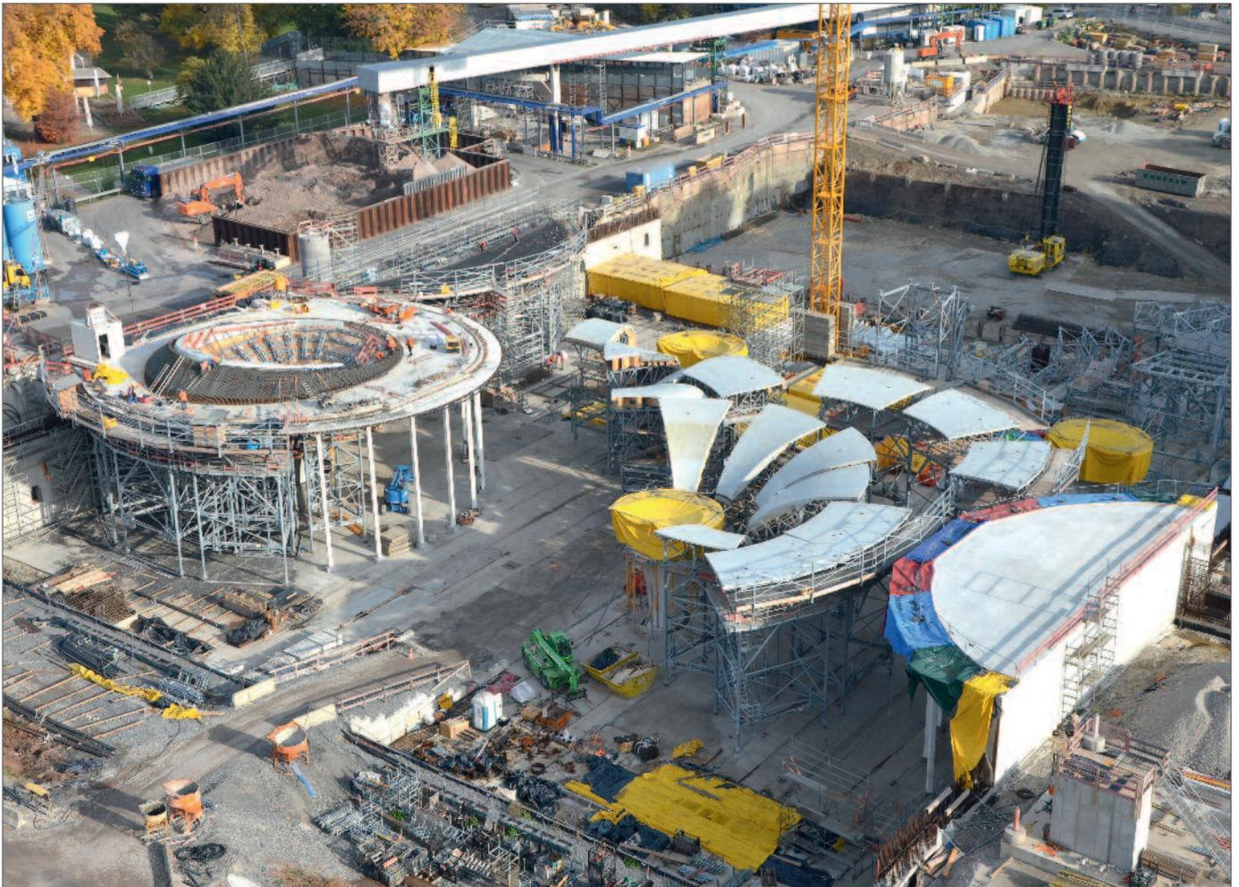
Rechts ist der fertige Restkelch zu sehen, auf der linken Seite sind die Arbeiten an der Hutze des Randkelches im vollen Gange, rechts daneben wird ein zweiter Restkelch bewehrt.
