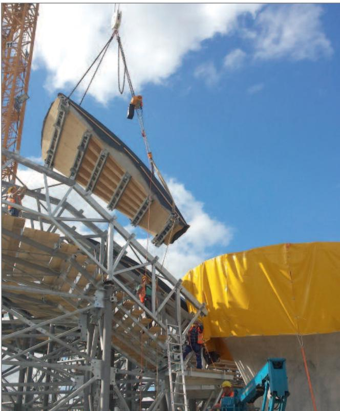
Abb. links: Nachdem die Türme „unten“ mit dem Holzbelag als Arbeitsfläche ergänzt wurden, konnten im nächsten Schritt die Türme „oben“ aufgestellt und die ersten Holzschalungs-Elemente montiert werden. Spannender Moment: die erste „Hochzeit“ von Turm und Schalung.
