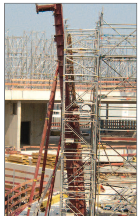
Geneigte Schalung 800 mm mit Sonder-Fußstück
