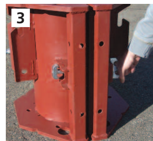
3. Hammerkopf der Verbindungsschraube um 90° drehen
