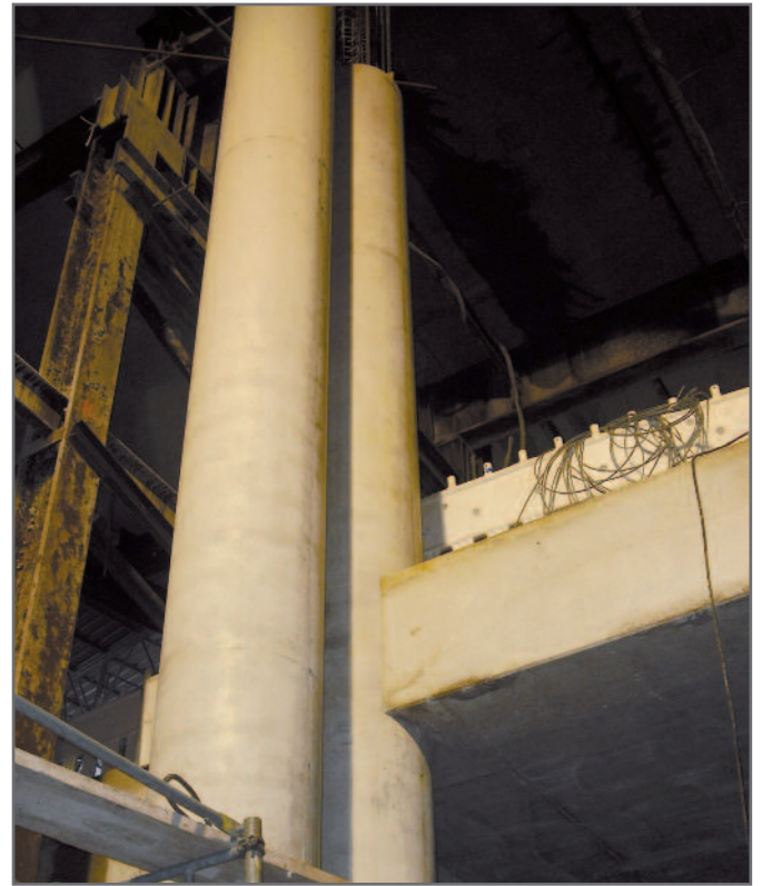
Stützen im U-Bahn-Bau, Höhen bis zu 12 m in einem Zug betoniert
