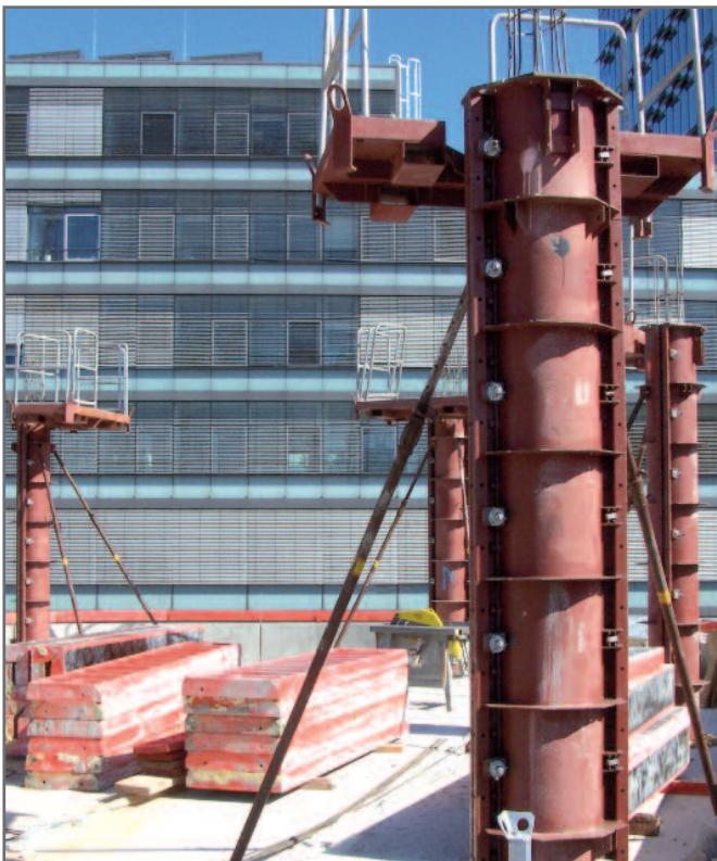
Schalungen mit Betonierbühne, für optimale Sicherheit beim Einbringen des Betons
