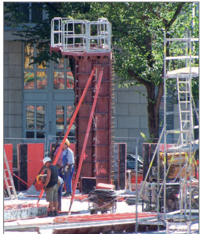
Stützen im U-Bahn-Bau, Höhen bis zu 12 m in einem Zug betoniert
