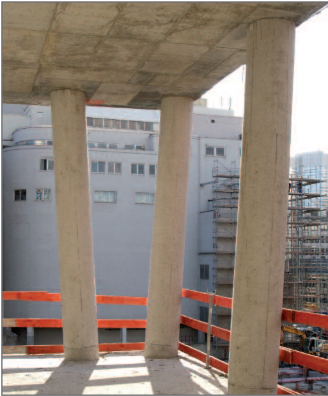
Geneigte Stützen, ausgeführt mit Mietschalungen und schrägen Sonder-Fußstücken
