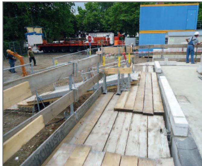
Es gibt natürlich auch sichere, bauseitig hergestellte, Lösungen mit Seitenschutz. Diese sind jedoch aufwändig herzustellen, die Tragfähigkeit wird oft „nach Gefühl“ bestimmt und nicht durch statischen Nachweis ermittelt.
