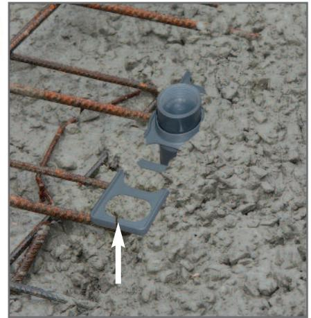
Der **Einbausatz mit Rödelfix** wird an der Bewehrungsmatte angerödelt und hält damit das PVC-Rohr in senkrechter Lage.
