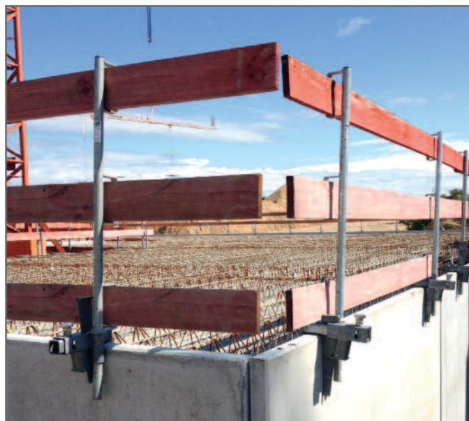
Einsatz als Einzelteil an der Außenschale bei bereits verlegten Deckenplatten
