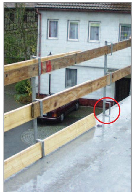
Seitenpfosten in Kunststoffrohren eingesetzt
