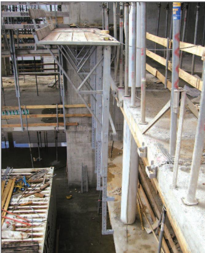
Einsatz von Klapp-Arbeitsbühnen mit langem Unterbau und Verlängerungsträgern, höhergehängt, an Lochfassade
