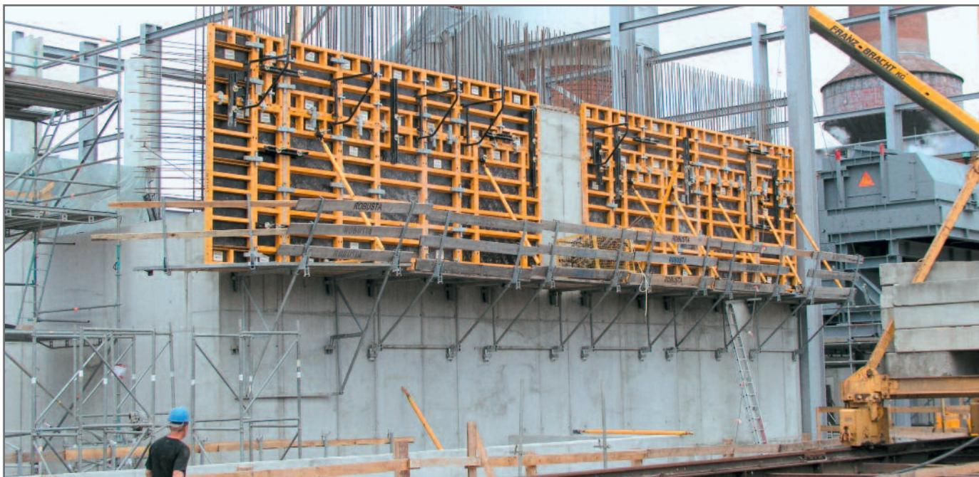
Die maximale Schalungshöhe für die Windlast aus Lastfall „Arbeitsbetrieb“ beträgt 4,50 m. Die Last der verankerten Schrägstütze wird von der Konsole allein ohne zusätzliche Verankerung der Wandschalung auf der Decke aufgenommen. Für das sichere Aufstellen und Abstützen mit Zug- und Druckstützen sind nur zwei Zubehörteile erforderlich. Das heißt: minimaler Aufwand für maximale Sicherheit!
