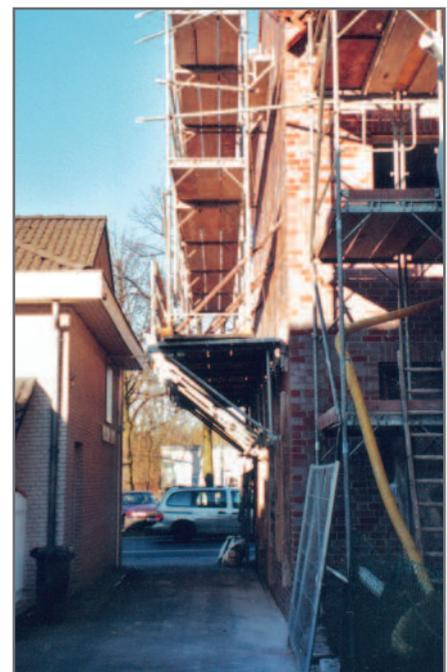
Nachträglicher Einsatz der Bühnen für Sanierungszwecke mit aufgestelltem Fassadengerüst, freie Durchfahrt für PKW während der Sanierungsphase
