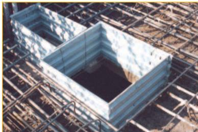
Auf Elementdecken werden die Schalboxen einfach mit Bindedraht an der Bewehrung angerödelt.
