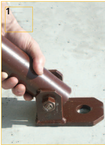
1. Anzuklemmendes Bauteil grob über dem Ankerpunkt positionieren
