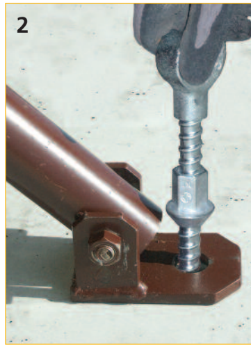
2. Schraube bis zum Ankergrund eindrehen
