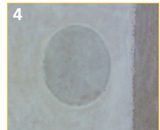
Es entsteht eine perfekte Sichtbeton-Oberfläche!
