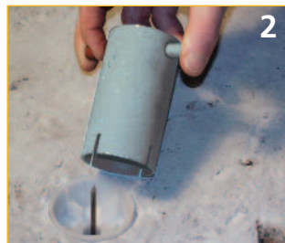
Ausdrehen des Klemmflansches nach dem Betonieren
