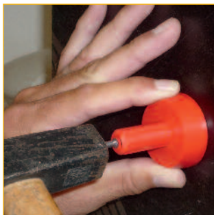
Klemmflansch einfach an der Schalhaut festnageln.
