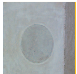
Es entsteht eine perfekte Sichtbeton-Oberfläche!
