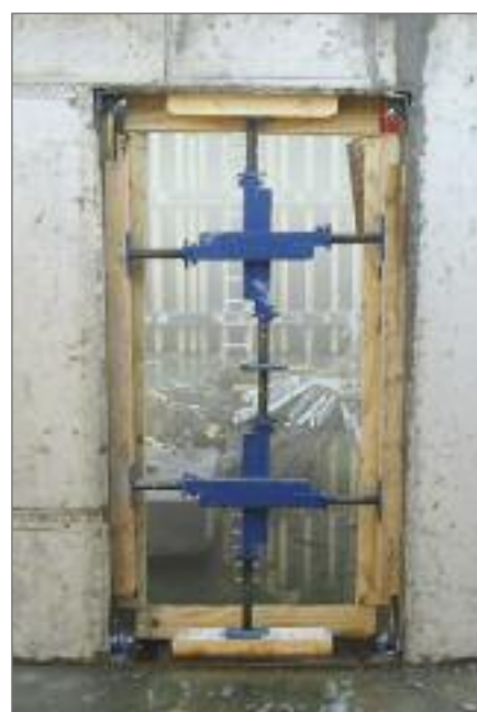
Nach dem Betoniervorgang anschließend einfaches Ausschalen der gesamten Aussparung
