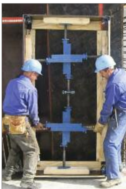
Aufstellen der Türaussparung
