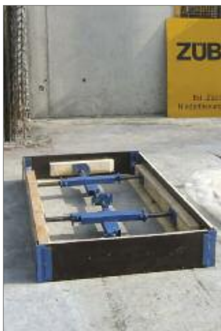
Fertig montierte Türaussparung mit 2 Schalkkreuzen: einfache Montage in liegendem Zustand
