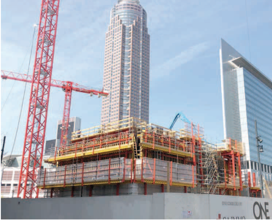
In der Frankfurter Skyline entsteht ein neues Büro- und Hotelhochhaus. Wiederverwendbare Stahl-Aussparungen sorgen für die Wirtschaftlichkeit beim Bauprozess. Quelle: Robusta-Gaukel
