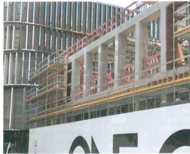
Bild 3 Nach dem Ausschalen: Fensteröffnungen mit höchster Sichtbetonqualität
