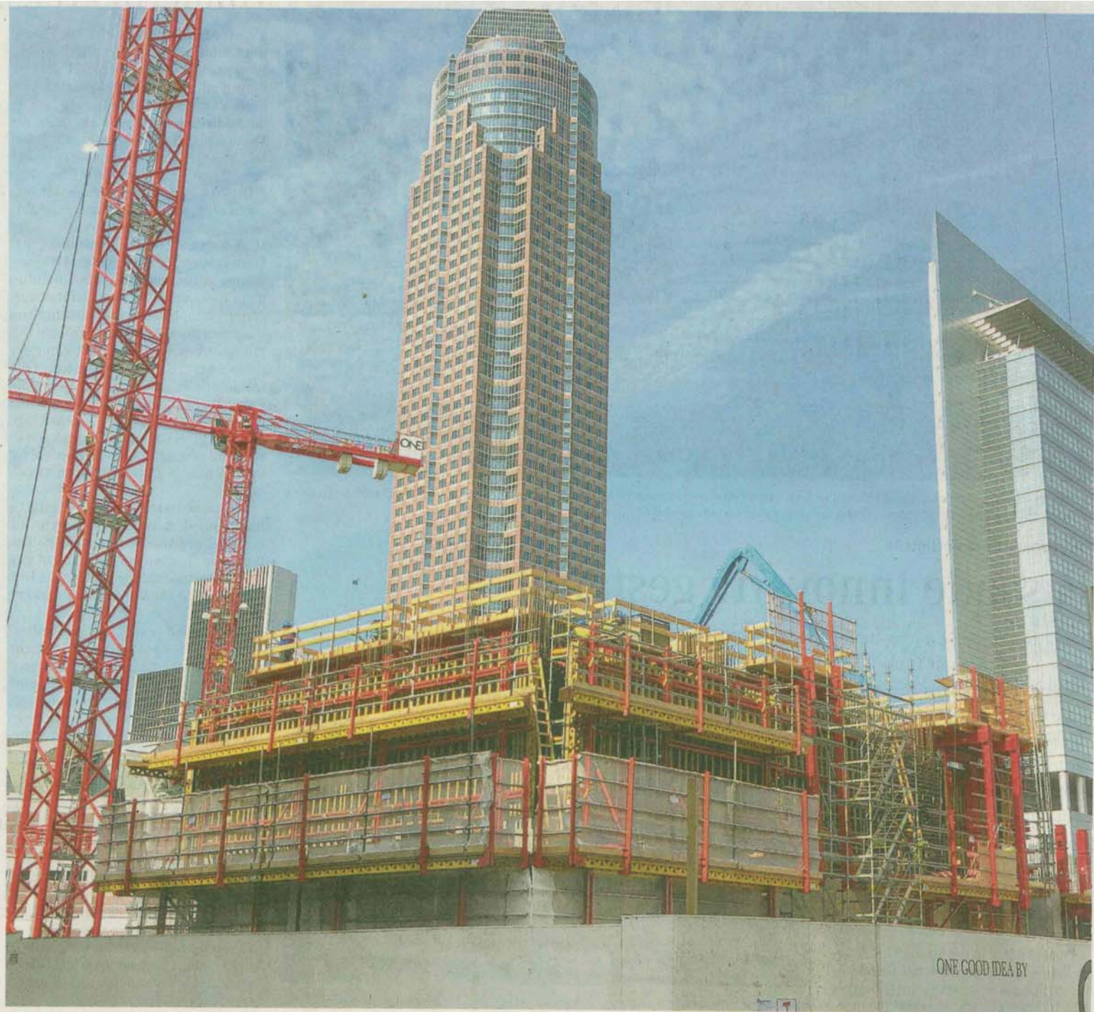
Das Büro- und Hotelgebäude „ONE by CA Immo“ entsteht auf 45 000 m 2 . Das 4-Sterne-Plus-Hotel soll 375 Zimmer, eine Skybar und eine großzügige Lobby bekommen.
