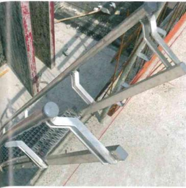
Überstehende Handläufe ermöglichen den sicheren Ein- und Ausstieg innerhalb der Steiltreppe.
