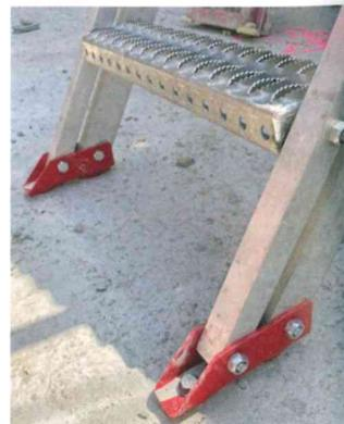
*Stufen aus rutschsicherem Profilrost mit gezahnter Oberfläche (RH R13) sollen die Sicherheit auf Baustellen zusätzlich erhöhen.*
