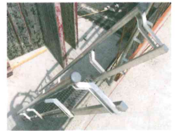
Überstehende Handläufe (mind. 1 m) ermöglichen den sicheren Ein- und Ausstieg innerhalb der Steiltreppe.
