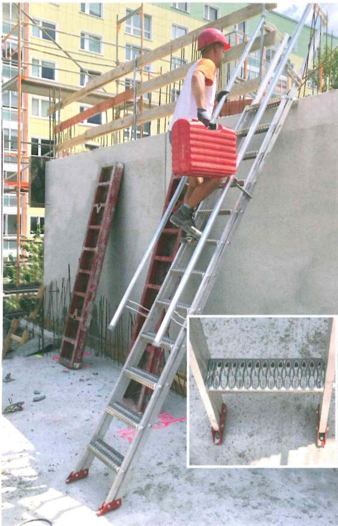
Sicherheit an erster Stelle: Stafe-Steiltreppe beim Dolgensee-Center, Berlin – MBN Bau AG | Foto: Robusta-Gaukel
