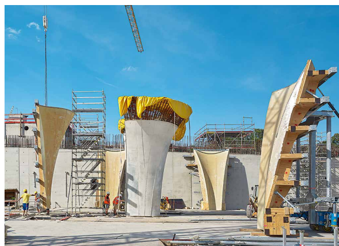
Bild 6. Ausgeschalter Kelchfuß mit den zugehörigen Schalungsbauteilen. (Achim Birnbaum)
