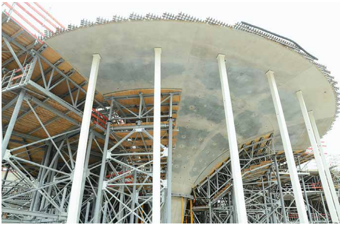
Bild 3. Regelkelch, teilweise ausgeschalt. Die ausgeschalteten Bereiche werden mit den sog. Notunterstützungen unterstützt, bis das gesamte Deckenfeld zwischen den Kelchen fertig gestellt ist. (ROBUSTA GAUKEL)
