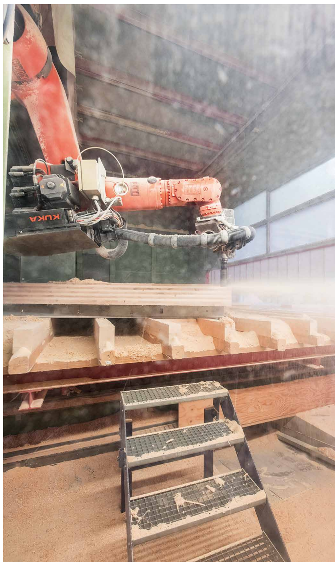
Bild 5. Gefräst wird mit einem CNC-Roboter. Ein Unterstützungsrost ermöglicht die millimetergenaue Abstimmung von Schalungselementen und Gurtungen. (ZÜBLIN Timber)
