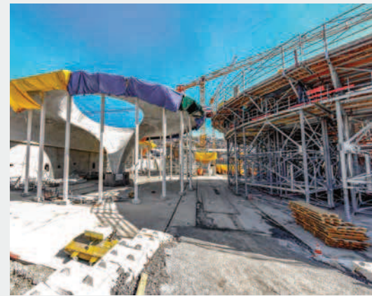
Meilenstein 2019: Der erste Randkelch, der im Dezember 2018 ausgeschalt wurde (links), und der erste Regelkelch, der eingerüstet ist (rechts).
