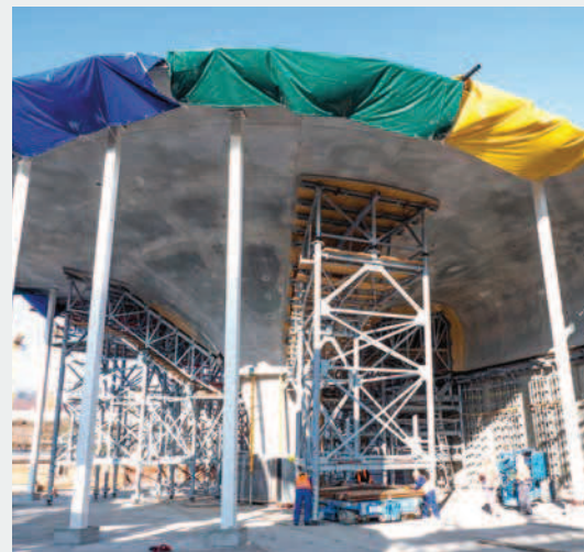
Ausschalarbeiten am ersten Randkelch: Dank Schwerlast-Plattformwagen gelingt das Umsetzen der tonnenschweren Rüsttürme mühelos.
