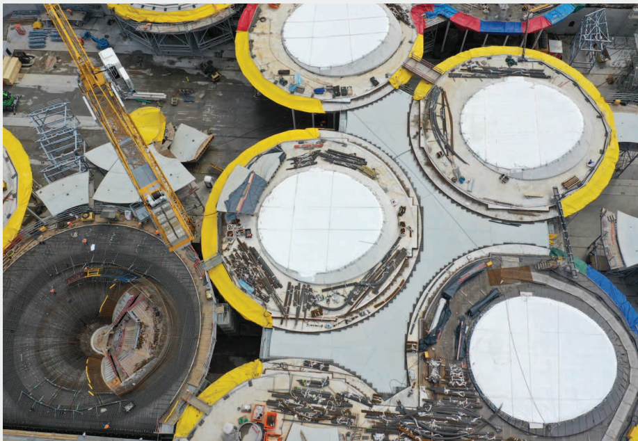
Beeindruckend: Die Schwindgassen zwischen den Kelchstützen wurden hier im zweiten Halbjahr 2020 teilweise betoniert.
