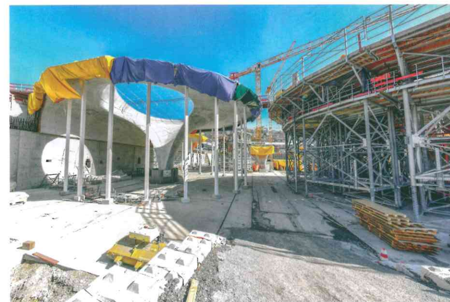
Meilenstein 2019: Der erste Randkelch, der im Dezember 2018 ausgeschalt wurde (links) und der erste Regelkelch, der eingerüstet ist (rechts). | Foto: DB/Arnim Kilgus
