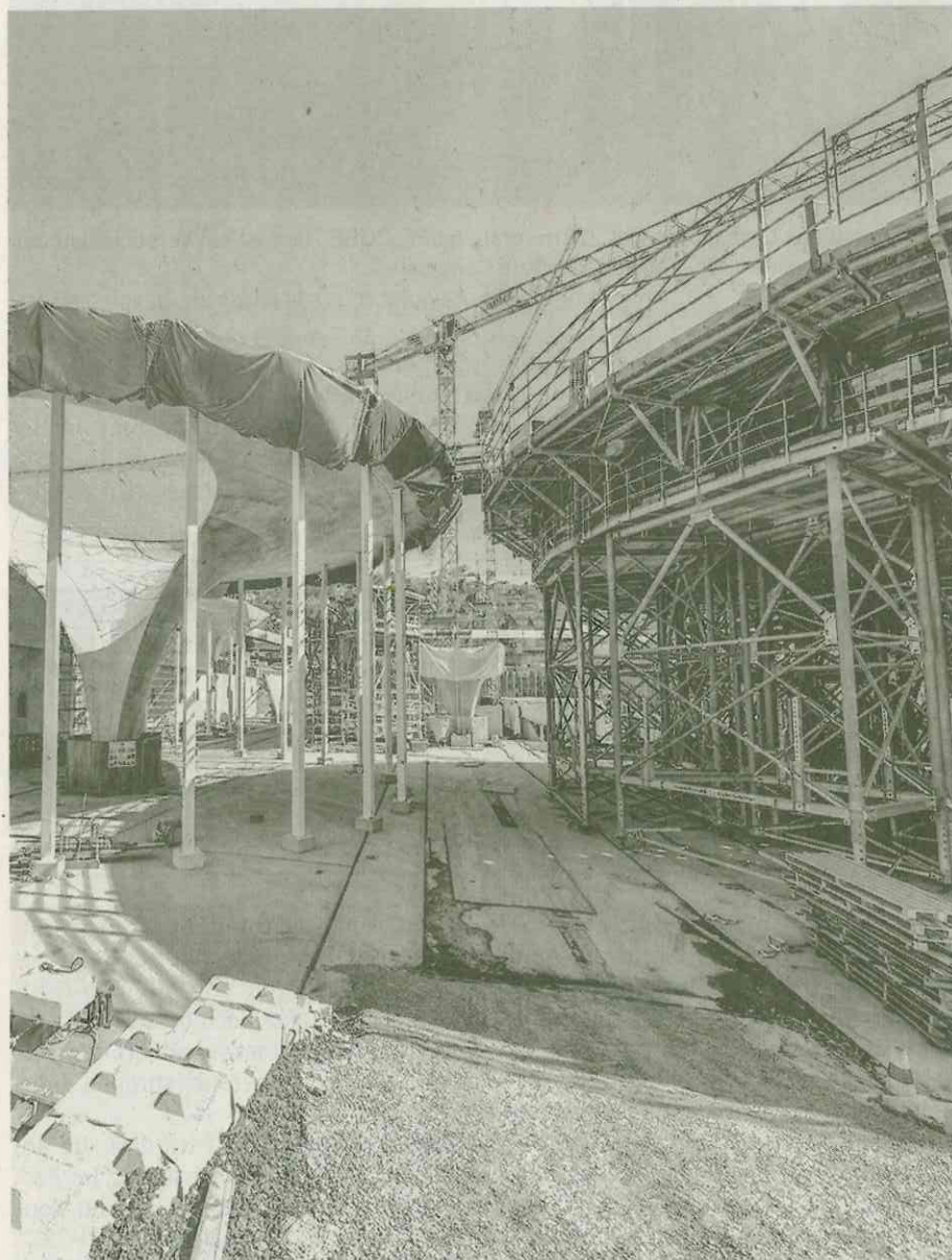
Meilenstein 2019: Der erste Randkelch, der im Dezember 2018 ausgeschalt wurde (l. im Bild) und der erste Regelkelch, der eingerüstet ist (r. im Bild). FOTO: DB/ARNIM KILGUS
