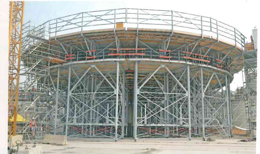
Eine derartige Betonform wurde noch nie zuvor realisiert, entsprechendes Neuland ist diese Spezialschalung für den ersten Randkelch. (Bild: Robusta-Gaukel)
