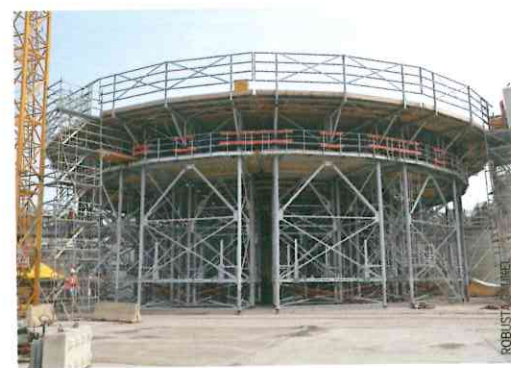
Komplett eingeschaltete Unterrüstung für den ersten Randkelch.
