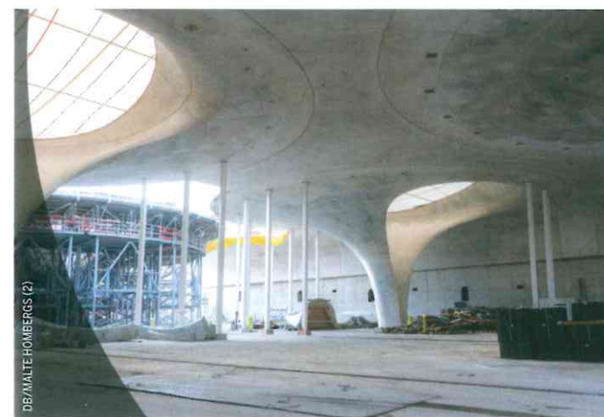
Schwindgassen – die Deckenfelder zwischen den Kelchstützen – verbinden die unterschiedlichen Kelchformen miteinander (li.). Sie wurden im 2. Halbjahr 2020 teilweise betoniert.
