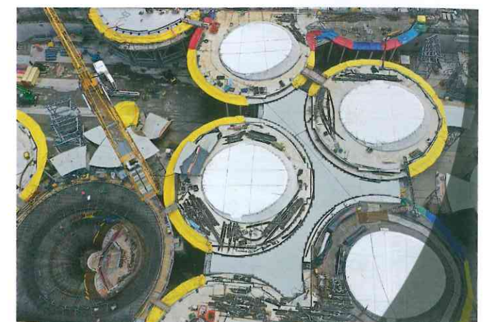
Schwindgassen – die Deckenfelder zwischen den Kelchstützen – verbinden die unterschiedlichen Kelchformen miteinander (li.). Sie wurden im 2. Halbjahr 2020 teilweise betoniert.
