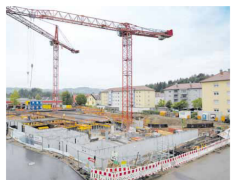
Das Basisgeschoss umfasst 4.500 Quadratmeter und ist eine Stahlbetonkonstruktion, ausgeführt als Weiße Wanne aus wasserundurchlässigem Beton.
