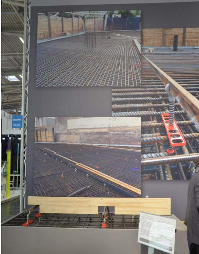
*BU: Rödelfix und Anschraubset als Gefälle-Lehre: Vermeidung von Gefahren durch nachträgliches Bohren in temperierten Decken- bzw. Bodenplatten.*
