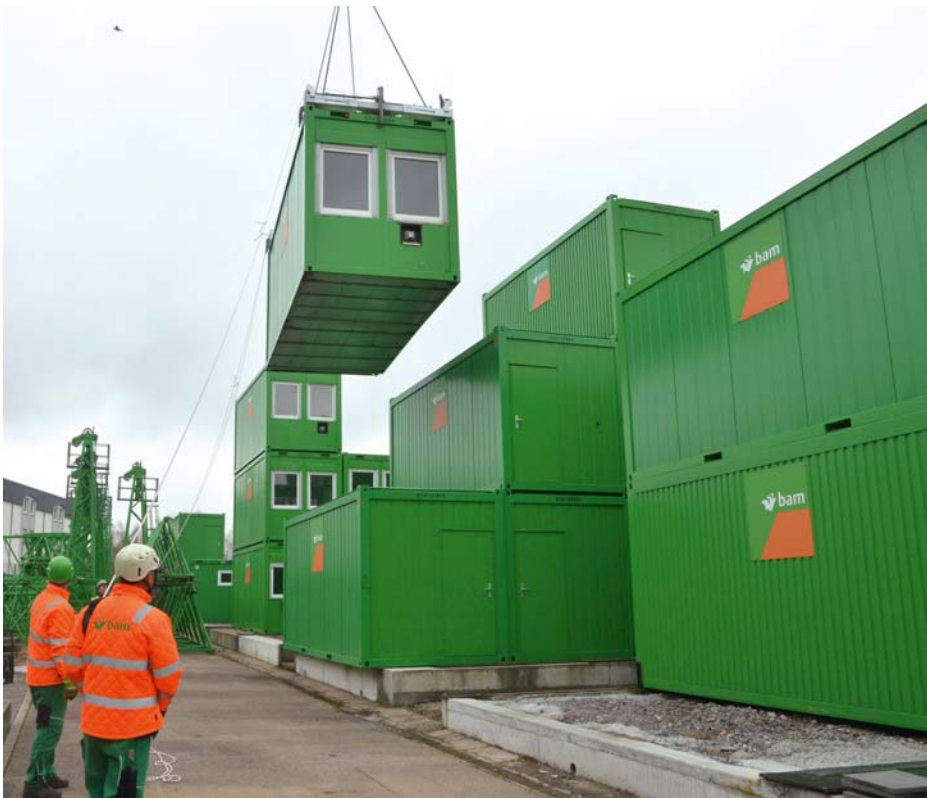
BU: Der ConFlex-Transportrahmen ist sicher, effizient und flexibel auf unterschiedliche Container-Abmessungen einstellbar. (Quelle: ROBUSTA-GAUKEL)
