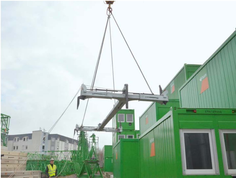
BU: Mittels Seilen kann ConFlex vom sicheren Boden aus verriegelt und wiedergelöst werden. (Quelle: ROBUSTA-GAUKEL)
