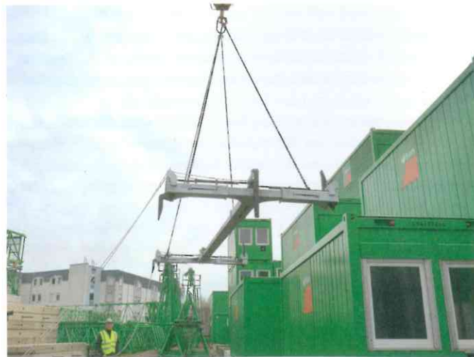
Bild 3 Mittels Seilen kann ConFlex vom sicheren Boden aus verriegelt und wiedergelöst werden.
