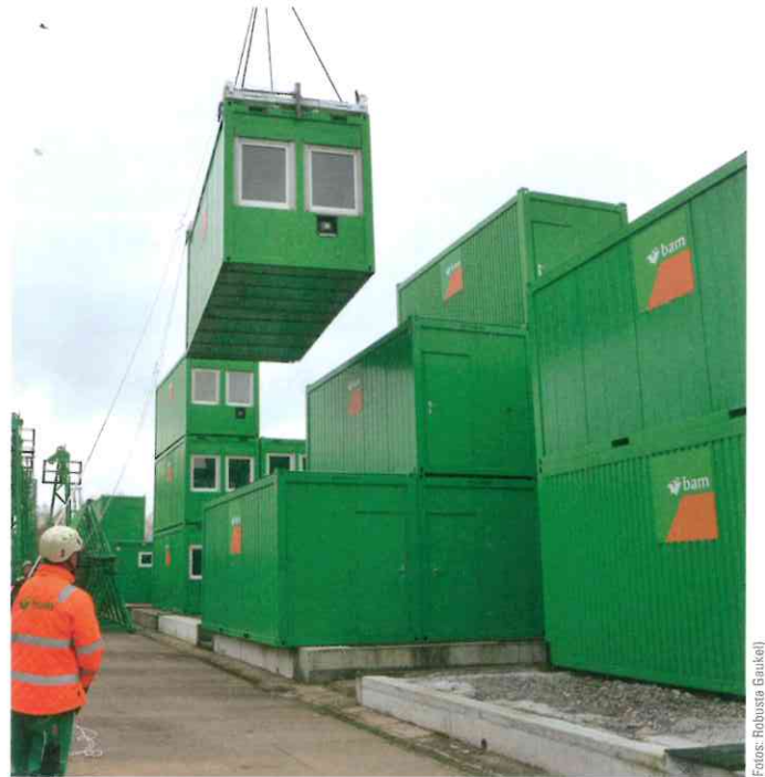
Bild 4 Der ConFlex-Transportrahmen ist sicher, effizient und flexibel auf unterschiedliche Container-Abmessungen einstellbar.
