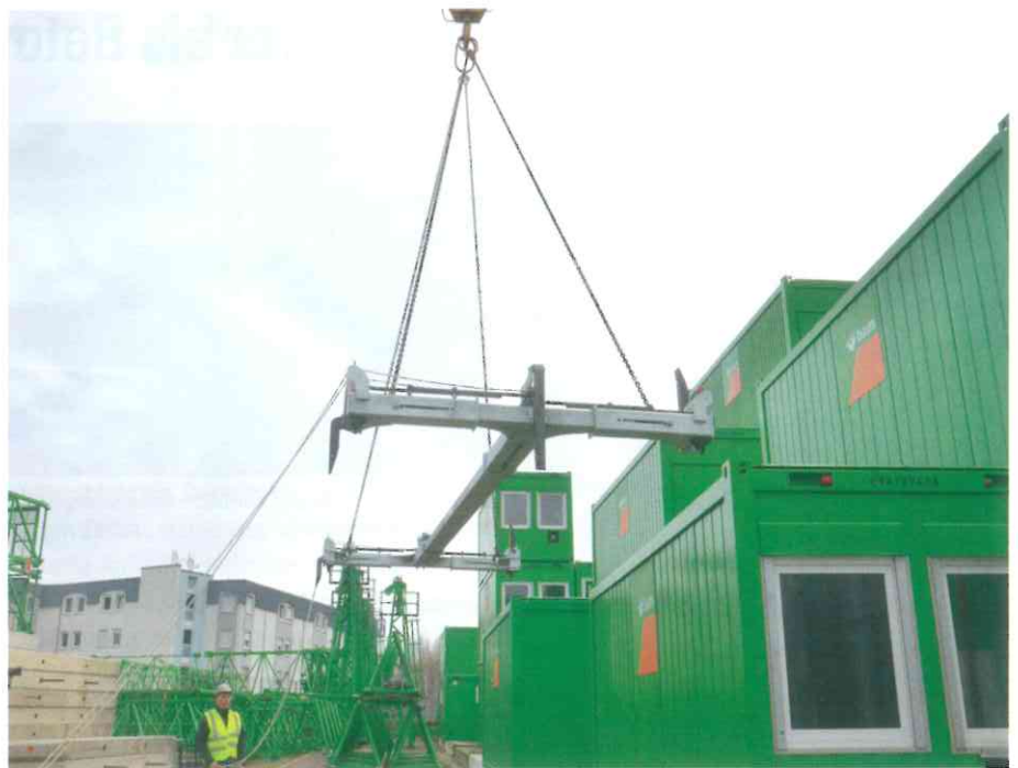
Mit dem „ConFlex“-Transportrahmen muss die Dachfläche der Container nicht mehr betreten werden, die Bedienung erfolgt immer vom sicheren Boden aus. | Foto: Robusta-Gaukel
