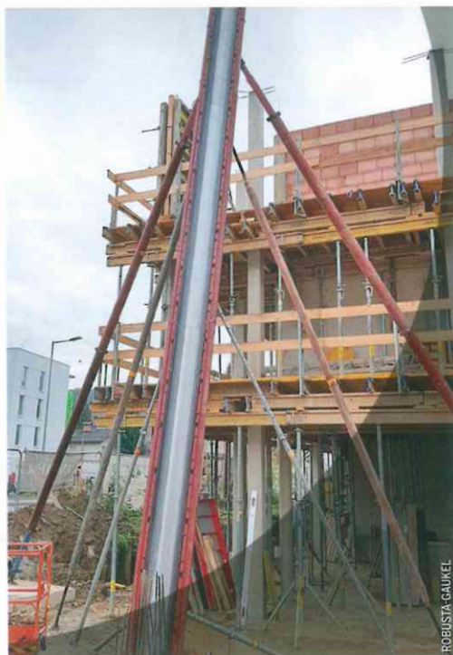
Die rechtwinklige Aufstandsfläche ermöglicht es die Schalungen ohne klaffende Fuge aufzustellen.
