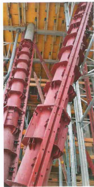
Passgenaues Zusammenfügen der Schalungshälften durch Zentrierstifte.
