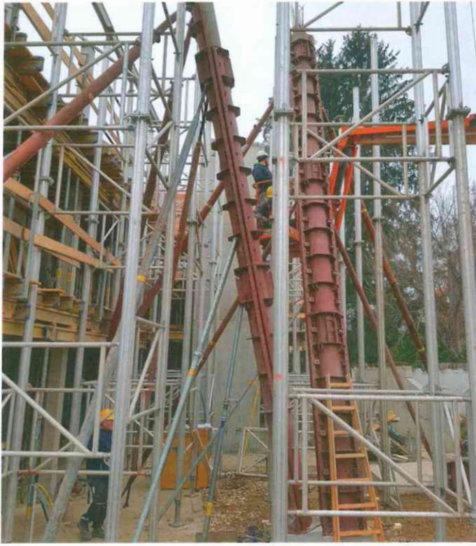
Die Rundsäulenschalung wird von Schrägstützen gehalten. Quelle: Robusta-Gaukel
