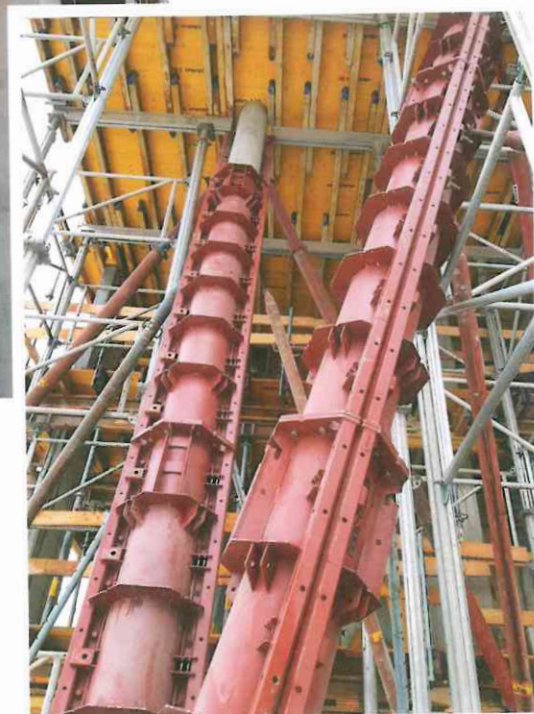
Die Schalungshälften lassen sich passgenau mit Zentrierstiften zusammenfügen. // Fotos (2): Robusta-Gaukel
