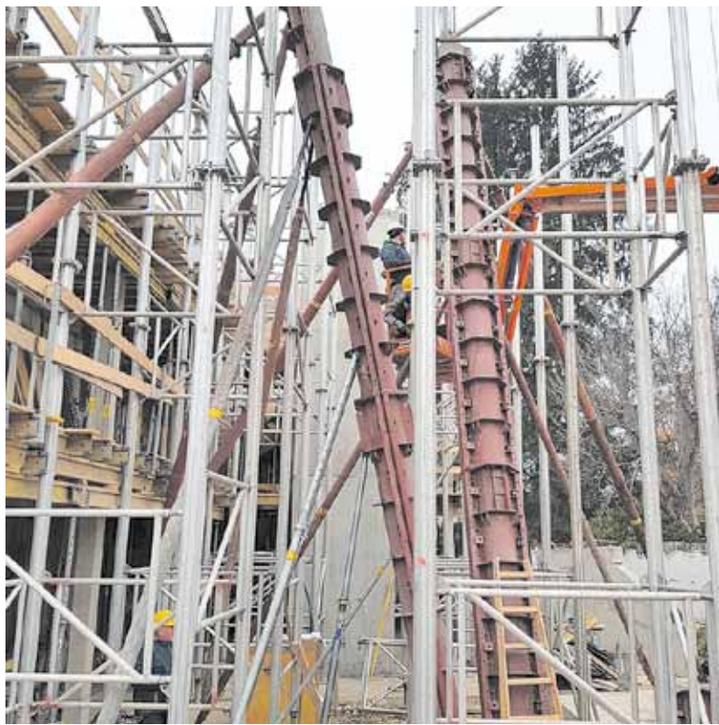
Anfang 2020 haben die Bauarbeiten für das Wohnhaus an der Radegunder Straße in Graz begonnen. Anfang 2022 soll es fertig sein.
