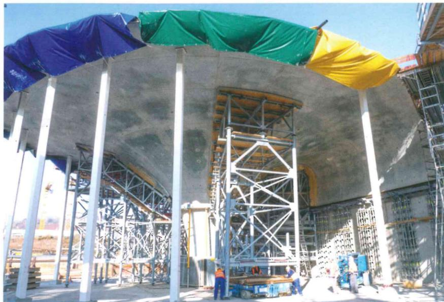
Ausschalarbeiten am ersten Randkelch: müheloses Umsetzen der tonnenschweren Rüsttürme mit dem Schwerlast-Plattformwagen. | Foto: DB
