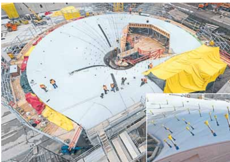
Winkelknoten sind vormontiert für schiefwinkelige Durchankerungen.
