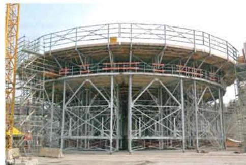
Imposanter Anblick: Die komplett eingeschaltete Unterrüstung für den Randkelch.
