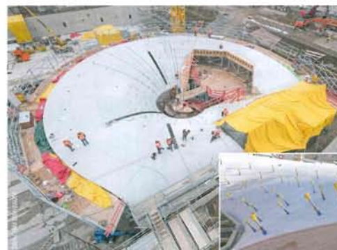
Winkelkonen sind vormontiert für schiefwinkelige Durchankerungen.
