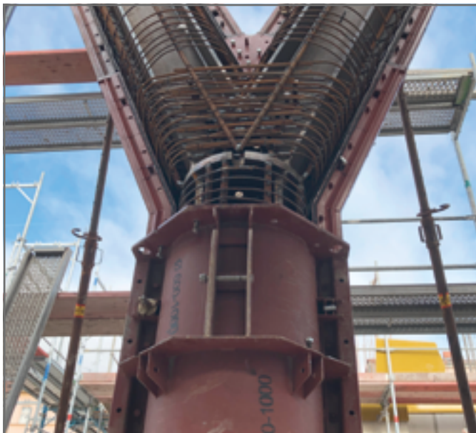
Y-Sonder Schalung in Kombination mit Rundsäulen-Schalungen
