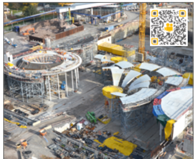
BV S21 Tiefbahnhof: Abstützung der Kelchstützen
