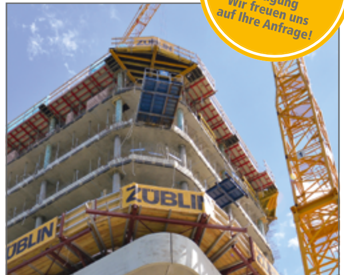
BV SKY Bietigheim: Sonderbühnen und Sonderkonstruktionen
