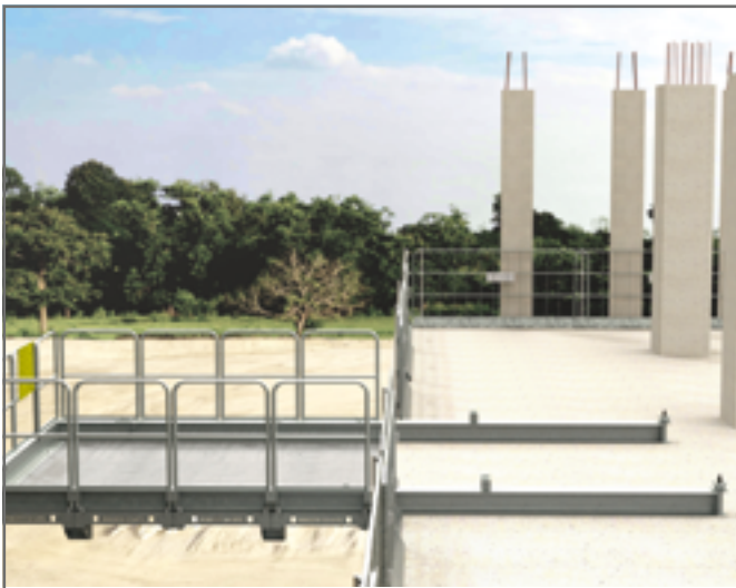
Befestigung durch Verankerung in der Bodenplatte
