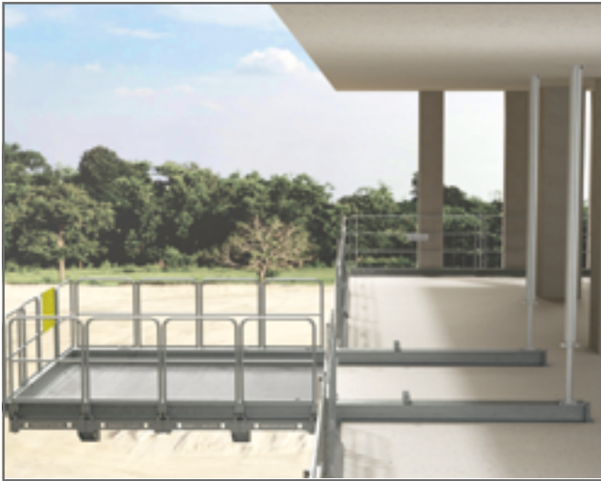
Befestigung durch Verspannen mit Aluminium-Deckenstützen
