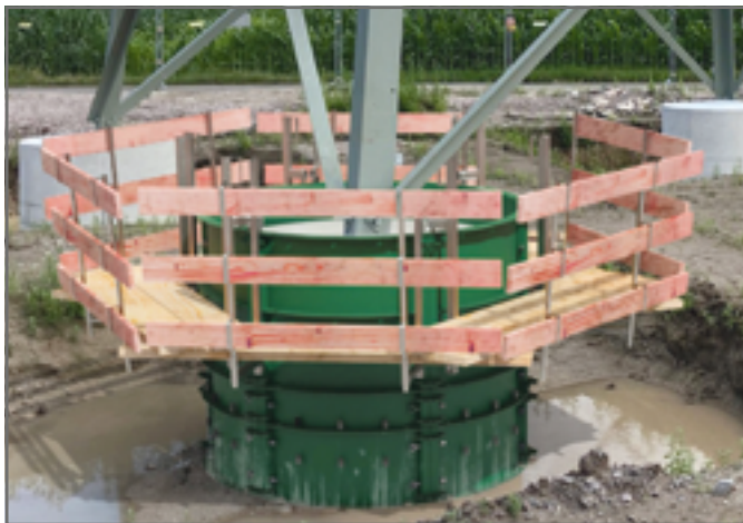
Sonder Schalungen für Mastfundamente
