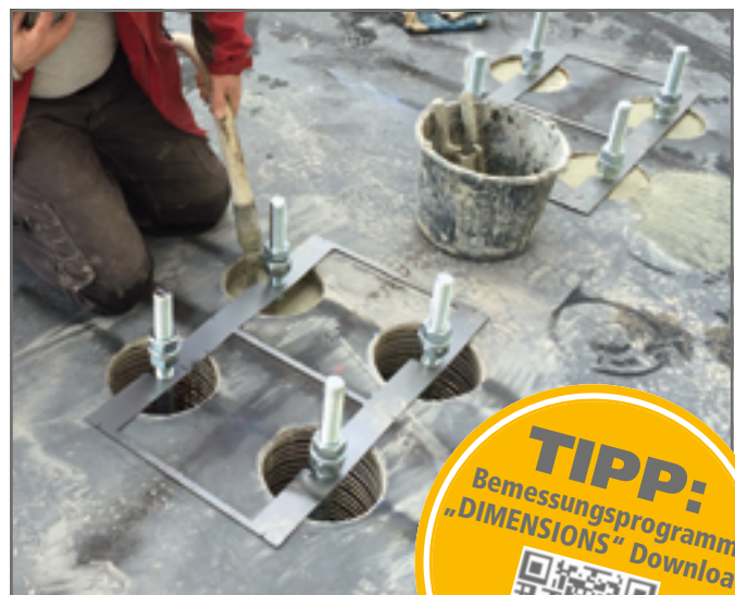
Verguss der Ankerstäbe mit Ankermörtel Hier Einbau 4-er Set mit Einbauschablone
