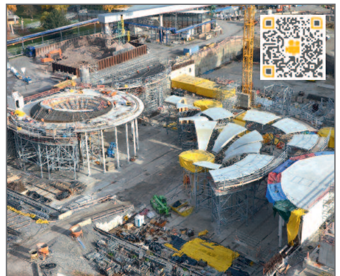
BV S21 Tiefbahnhof: Abstützung der Kelchstützen
