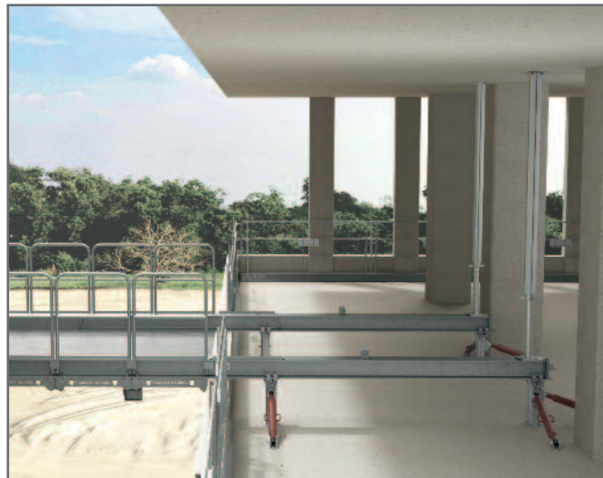
Montage auf Brüstungen
