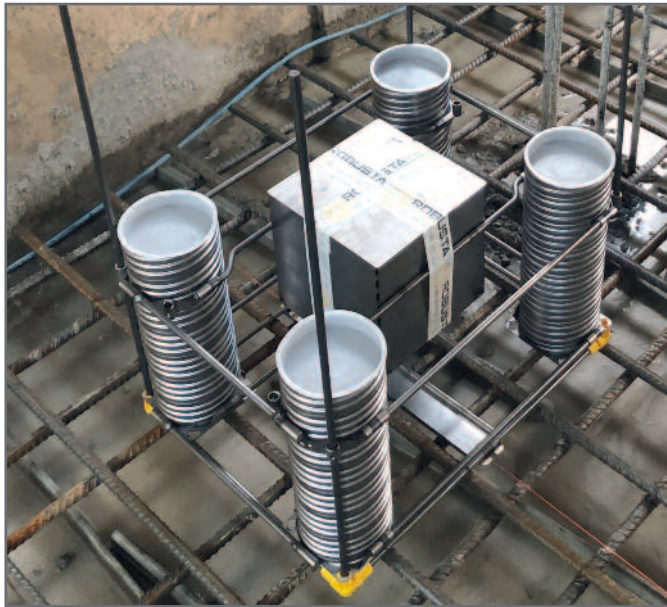
Befestigen des Montagerahmens an der unteren Bewehrungslage mit Draht hier komplettes Einbauset, 4-fach, mit Schubknappe und zentraler Einmessschablone
