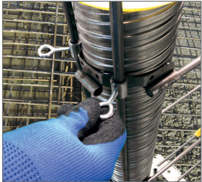
Fixieren des Verankerungs-Sets an den senkrechten Stäben des Montagerahmens nach dem Einstellen der korrekten Höhe. Dies kann vor oder nach dem Verlegen der oberen Bewehrungslage erfolgen.
