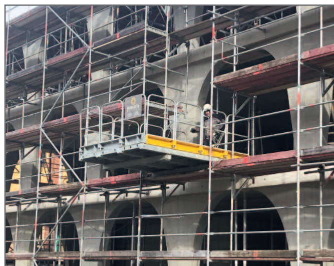
Befestigung mit Abstützung unter der Decke
