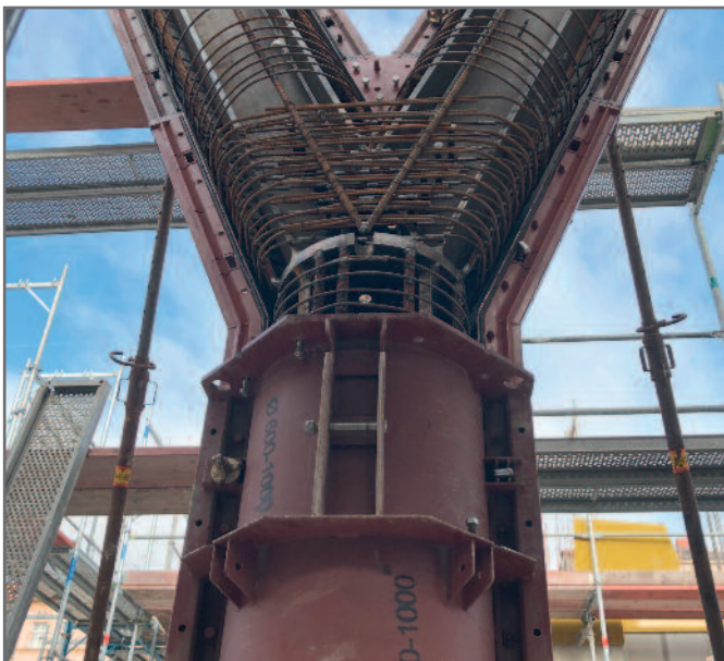
Y-Sonderschalung in Kombination mit Rundsäulen-Schalungen
