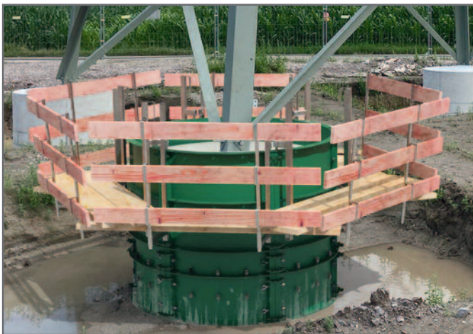
Sonderschalungen für Mastfundamente
